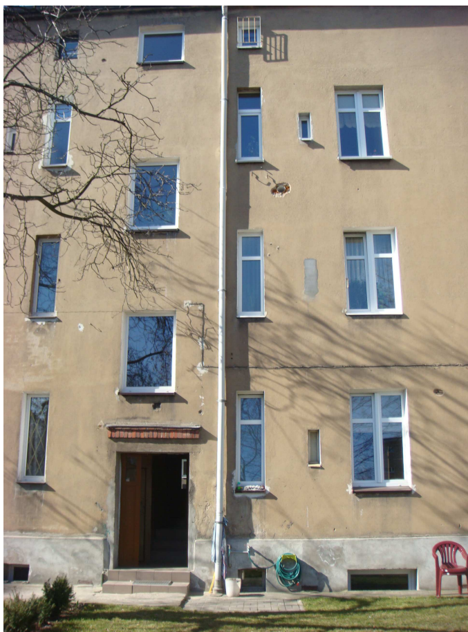
Fot.3 Elewacja tylna
