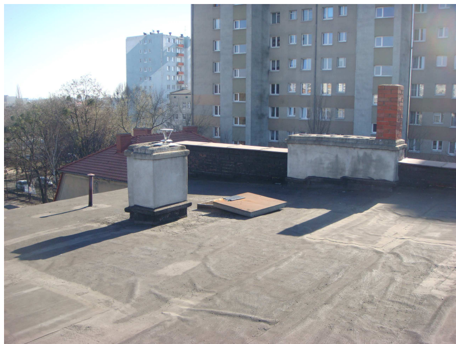
Ilustracja 1: Fot. 4 Fragment dachu
